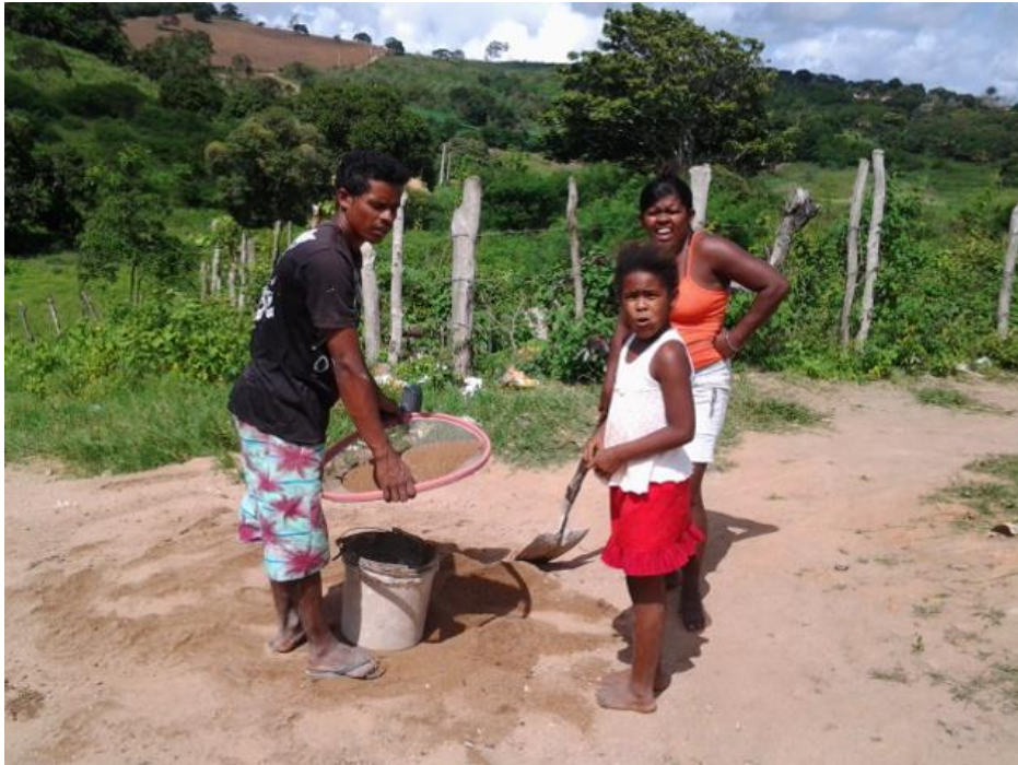
Figura 23 – Construção de Cisterna
