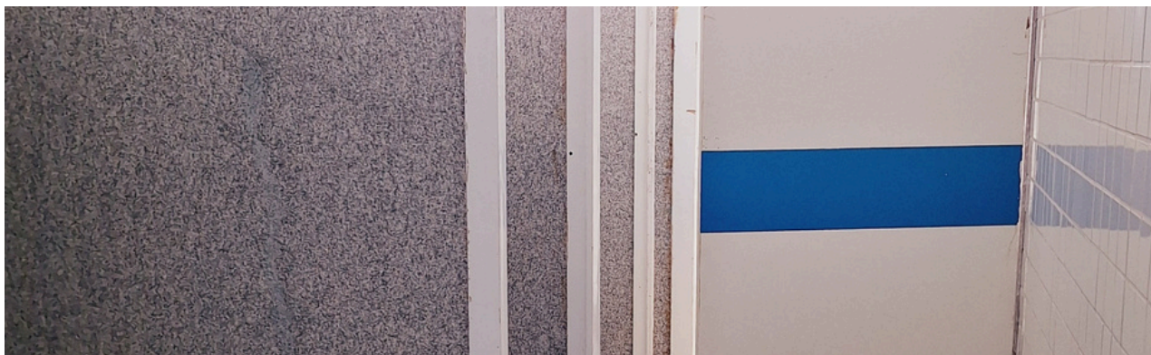
Imagem 6 - Banheiros para pessoas deficientes
